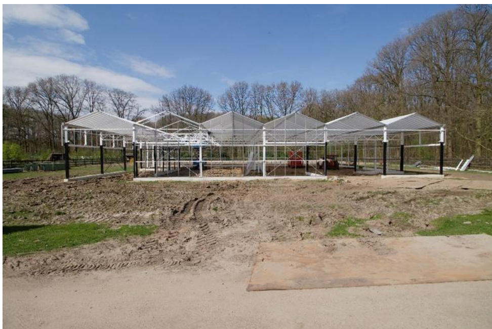
De kas in aanbouw
